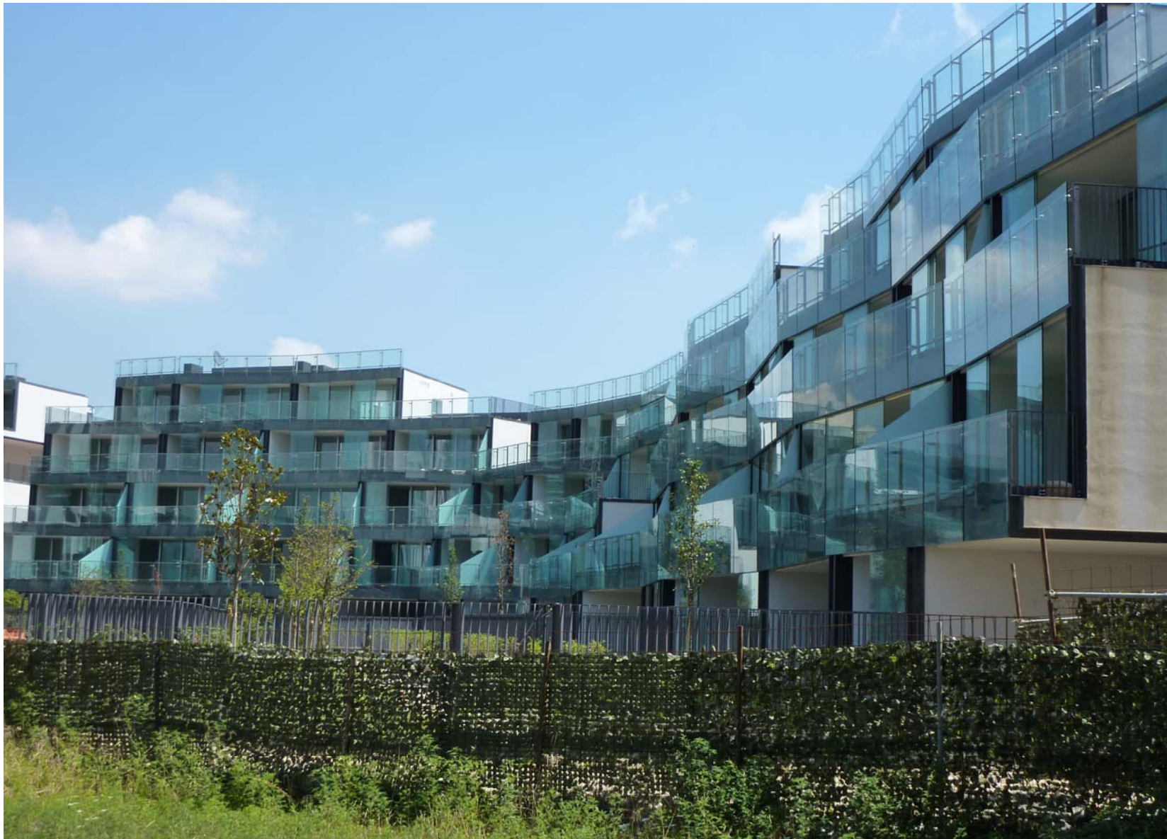
ASSAGO (MI) – Complesso residenziale MilanoFiori (Milanofiori 2000 srl, Studio OBR, 2010) Progetto costruttivo impresa CNS - Milano dei componenti architettonici vetrati scorrevoli a completa trasparenza e chiusura dei giardini a terrazza.
