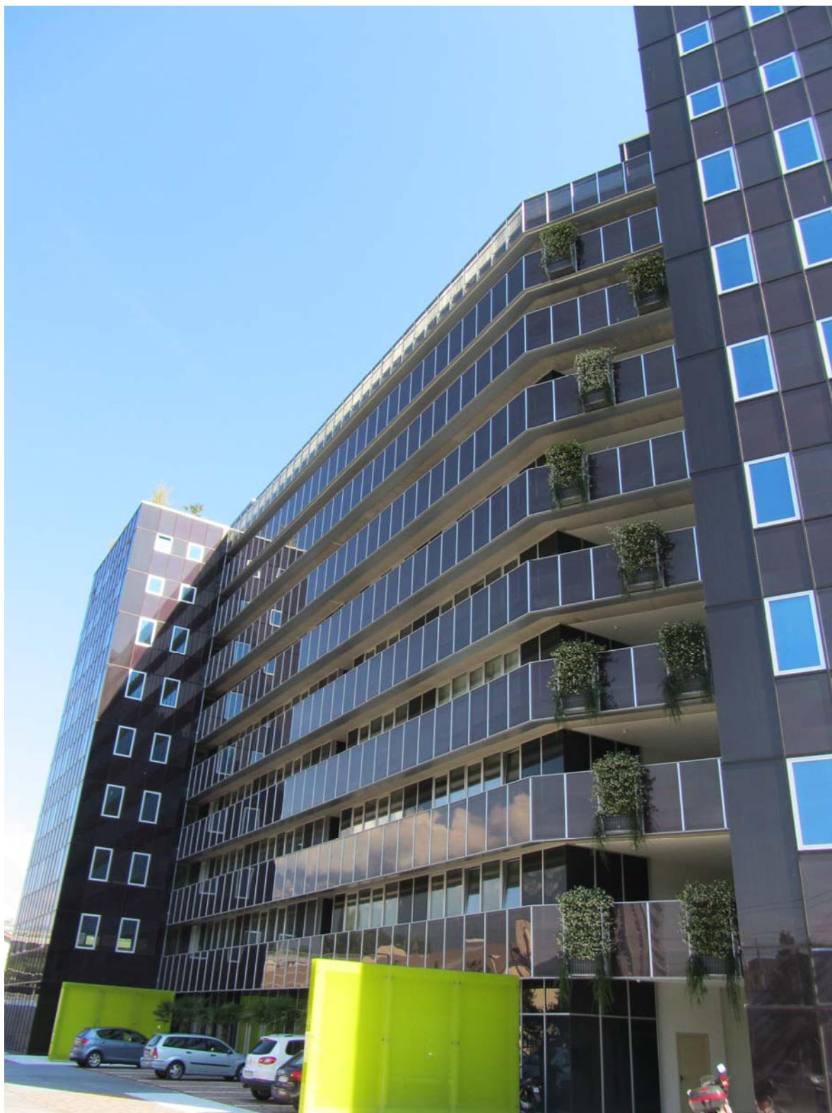
BOLZANO – Enzian Tower – (Arch.Bampi Zeno+ Ing.Siegfried Pohl, 2010) Studio di facciate continue integrate con pannelli fotovoltaici aventi l'obiettivo di realizzare edificio autoalimentato mediante energia solare e a connessione alla rete elettrica Enel per recupero economico di extraproduzione ; analisi di vari modelli di tamponamento sia opaco che semitrasparente per la ottimizzazione tra costi dei tamponamenti e rendimenti, anche con confronto di varie tipologie di PV del tipo a silicio amorfo e monocristallino ; impiego di sistemi di facciata a basso consumo energetico classe Casa Clima A
