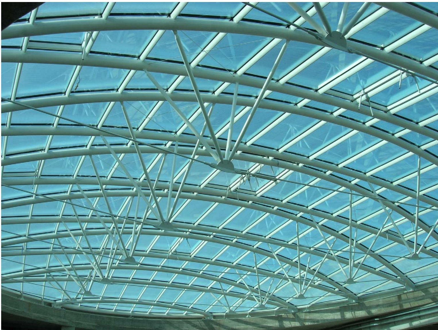
CASERTA – Centro commerciale ISE (arch. Ferdinando Iodice, 2005) Coperture a volta a base ellittica con strutture a lenti formate da doppio tubolare calandrato e tiranti, con vetro camera del tipo a siliconi strutturali; disegno completamente realizzato in 3D con uso di modellatori solidi per Inventor e Mechanical 2005, lato maggiore della cupola di 50 m.
