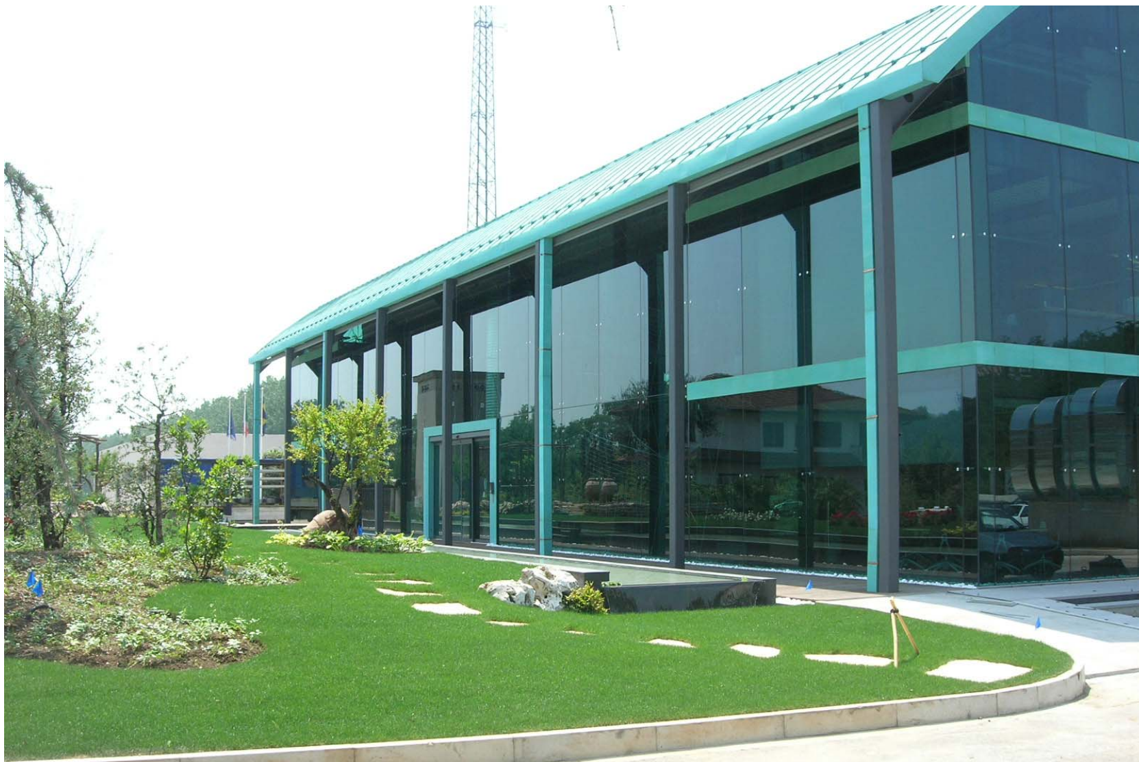
VARESE – Sede ZMC (arch. Riccardo Papa, 2006) Tensostruttura verticale con tralicci portanti in funi inox intrecciate poste a supporto del vetro esterno fissato mediante snodi puntuali; la facciata a tutta altezza, posta a chiusura della Hall di ingresso, si prolunga sui lati dell'edificio ove il sistema portante si modifica con diversa struttura a doppie lame in acciaio a sbalzo dai solai sulle cui estremità si fissano le staffe stellate portanti i vetro.
