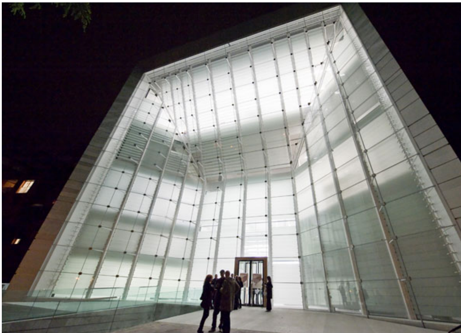
BOLZANO – Museion (Rizzani De Eccher / Vega Systems - arch.studio KSV-Berlino, 2008) Ingegnerizzazione dei sistemi di tensostruttura delle facciate in vetro, calcoli statici FEM ad elementi volumici dei morsetti delle funi e vetri, calcoli a post-rottura dei vetri e dimensionamenti delle lastre ; disegni dei particolari di fabbrica di ogni componente della pelle esterna , con controllo 3d della congruenza spaziale dei vari piani di facciata
