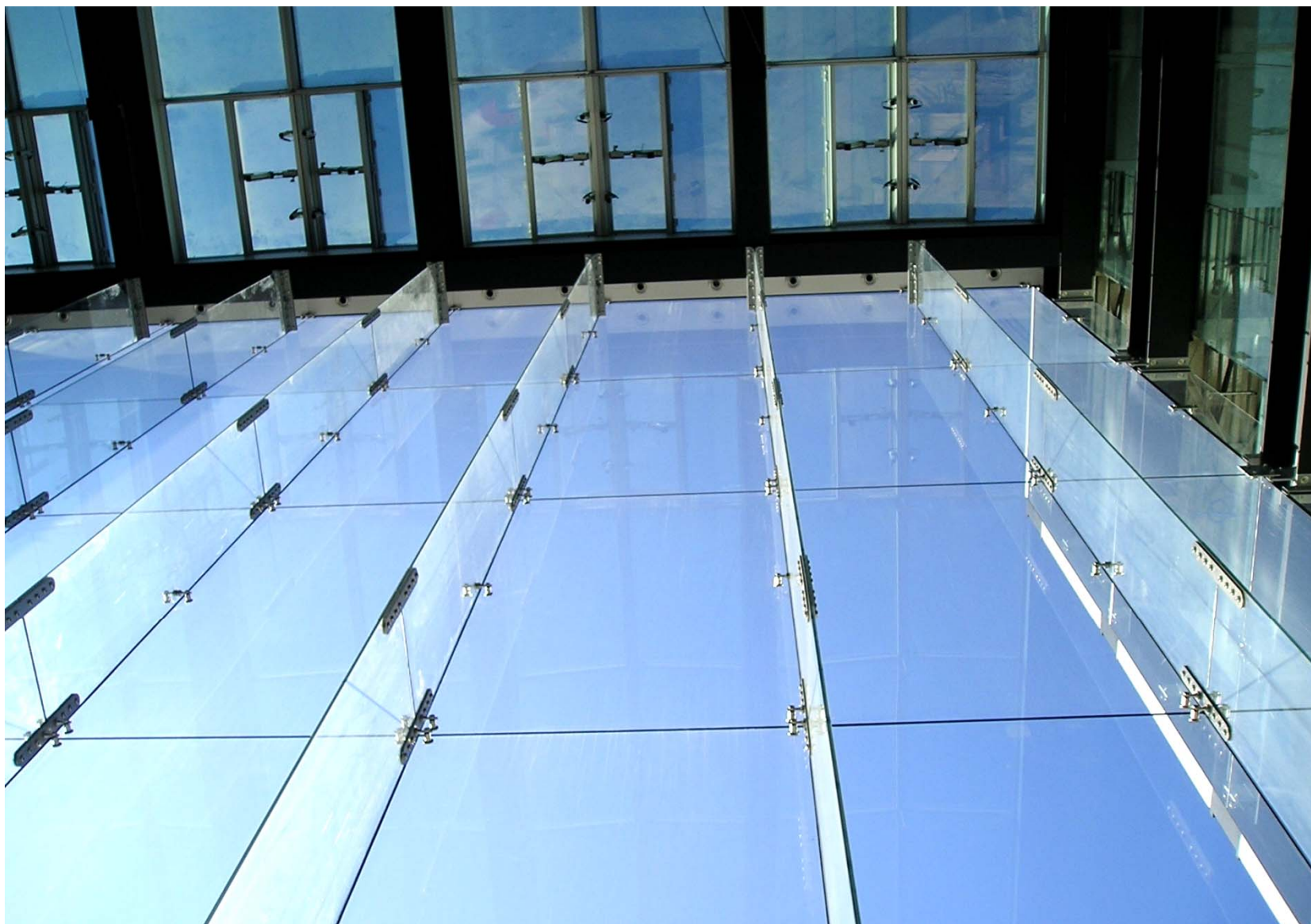
PADOVA – Net Center (Arch. Aurelio Galfetti, 2003) Studio del sistema di partizioni sospese in vetro con strutture portanti realizzate in lame di vetro di altezza di 17,5 m; sviluppo dei disegni dei particolari di messa in produzione, e analisi dei sistemi di controllo di produzione e posa.
