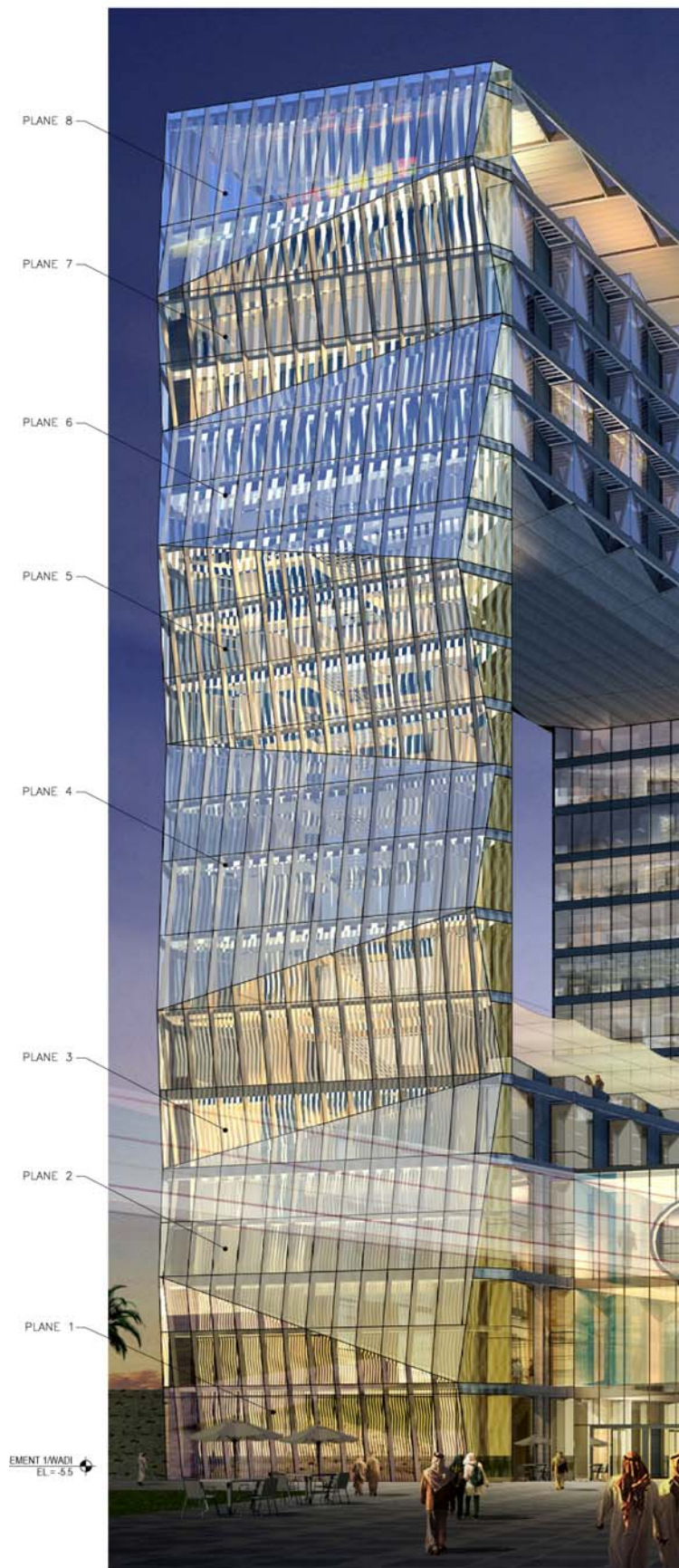
RIYAD – KAFD, Hotel Building – (Giugiaro Architettura, in corso) Progetto costruttivo dei componenti di facciata a grandi pannelli con utilizzo di strumenti di disegno 3D parametrici
