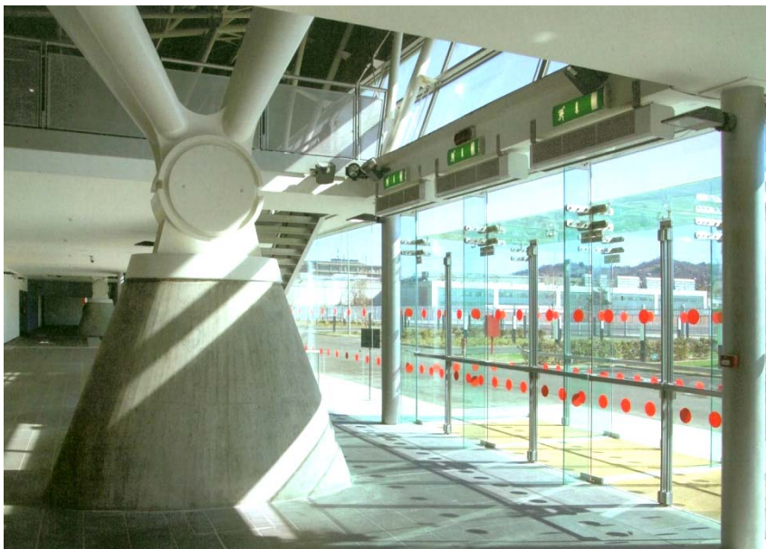
TORINO – PalaOval (Arch. Alessandro Zoppini, 2006) Schema di calcolo utilizzato per la verifica strutturale degli elementi di ingresso realizzati in vetro portante monolitico da 19 mm. Le connessioni tra le lastre vetrate sono realizzate con staffe e bulloneria in acciaio inox.
