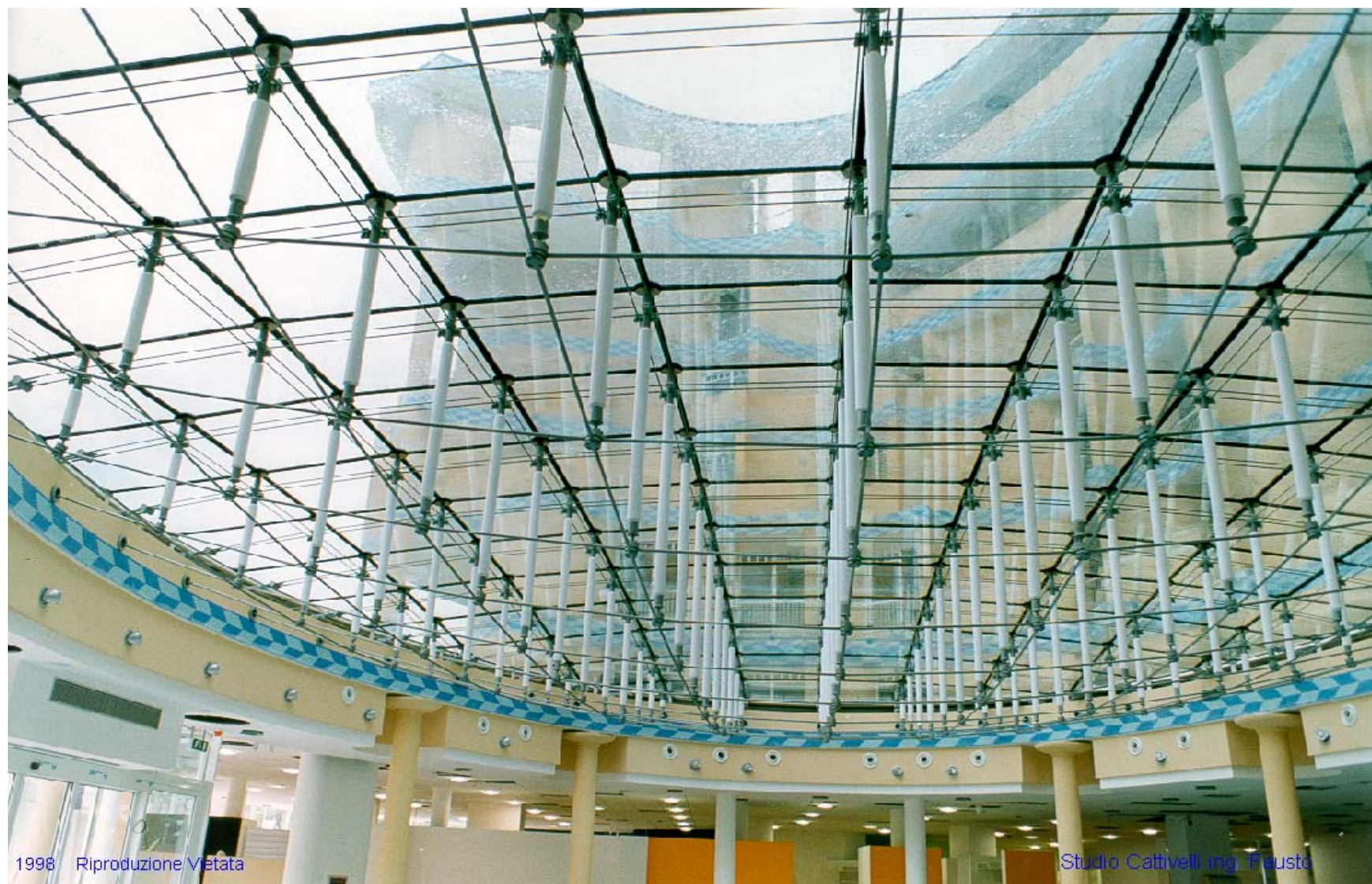
RIMINI – Copertura Hotel Savoia (Arch. Prof. Paolo Portoghesi, 2001) Tenso-copertura a doppia rete di funi e vetri supportati a punti con speciali appoggi di specifica applicazione a progetto
