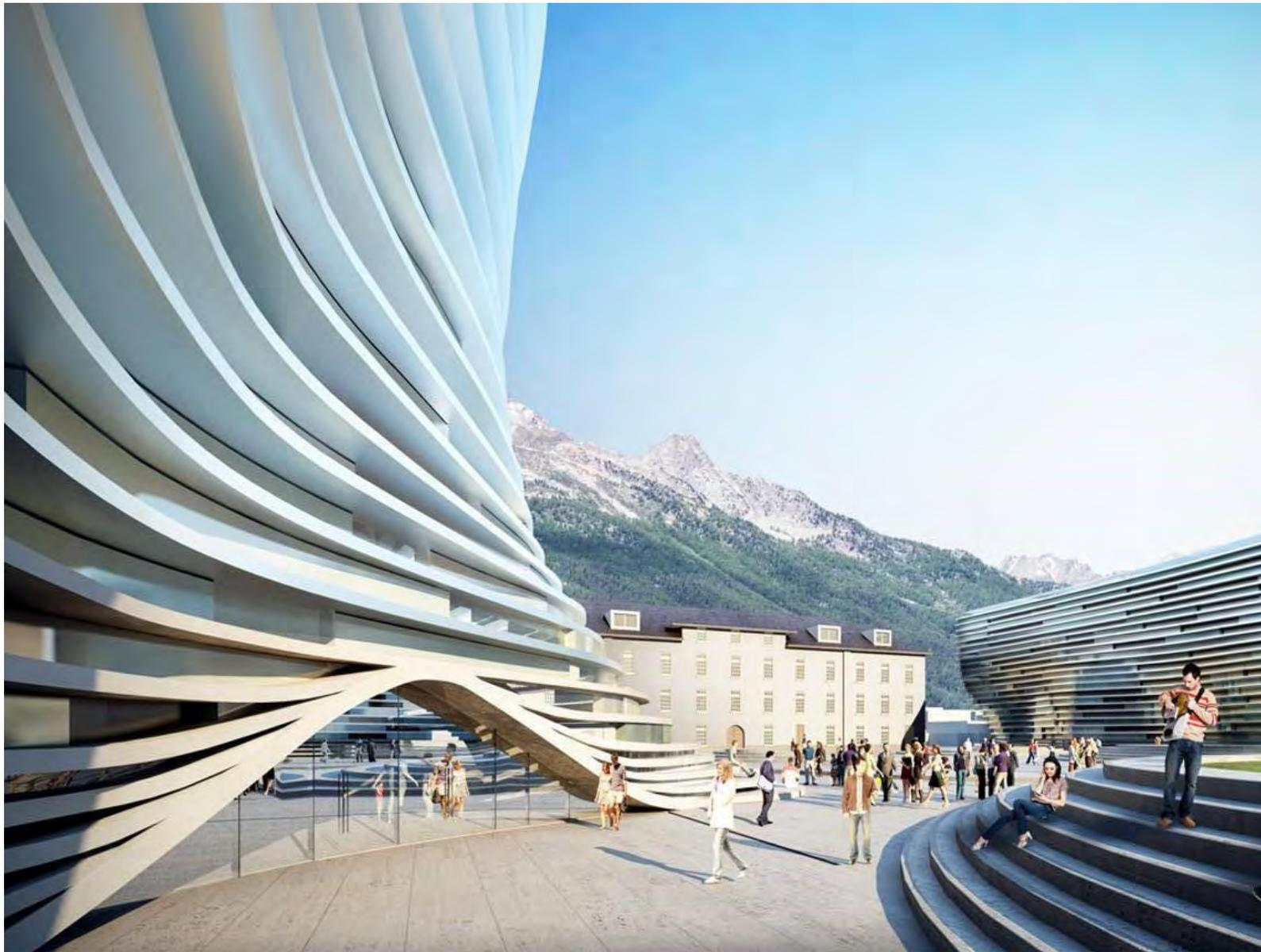
**AOSTA – Nuova sede Universitaria – (MCArchitects – in corso)** Progetto costruttivo. La facciata a tutta altezza che racchiude la grande hall dell'edificio è costituita da una struttura portante in "centine" d'acciaio sagomate, a sostegno di un rivestimento realizzato da cassoni orizzontali in termoplastico e tamponamenti verticali in pannelli di lamiera isolati e vetri-camera inseriti in guide a taglio termico
