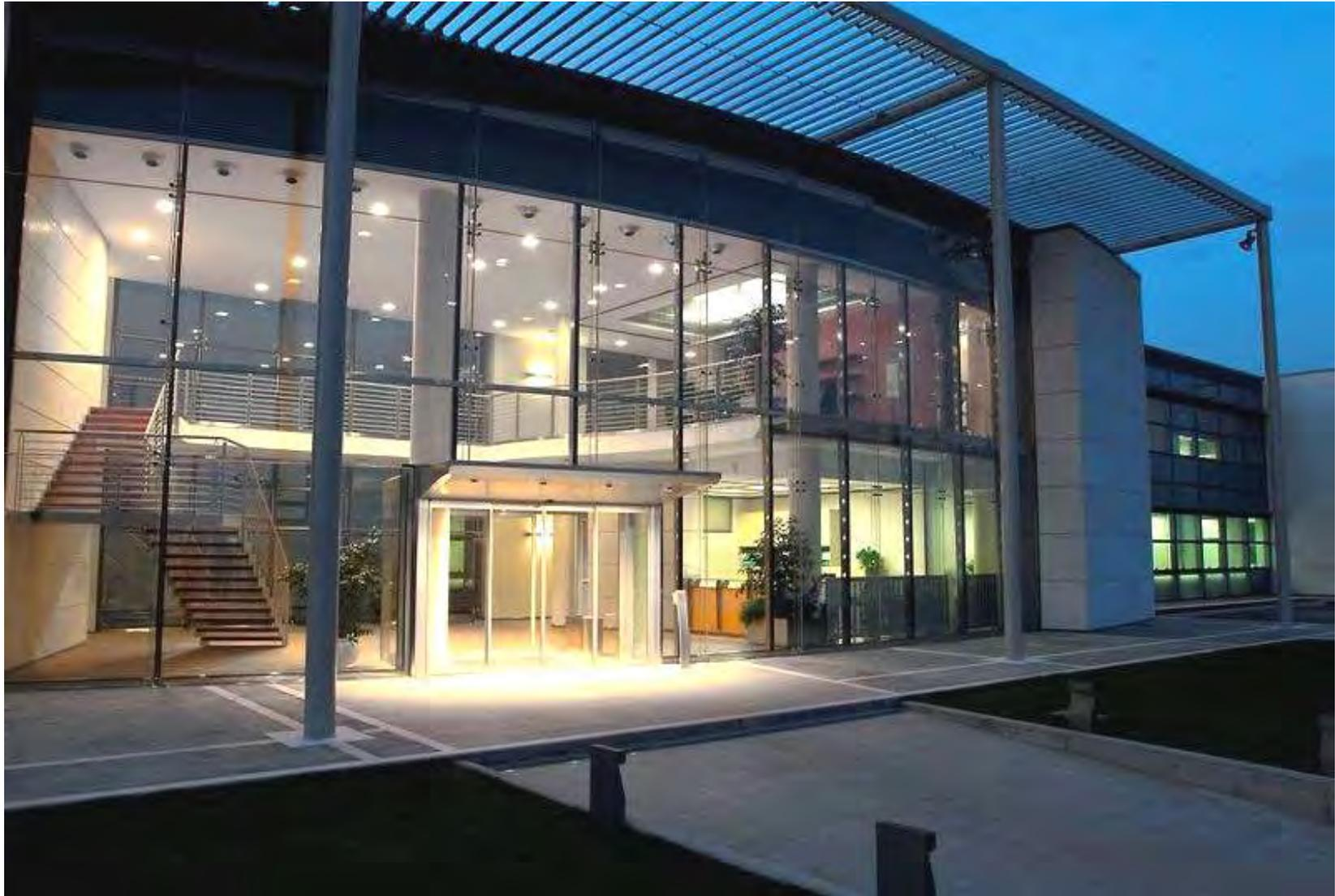
**TREVISO – Sede OGP (Ing. Giuliano Magnoler, 2003)** doppia pelle a pianta curva, basata sul principio del risparmio energetico a riciclo di fluidi in stagione sia estiva che invernale; pelle esterna realizzata con travi in vetro e fissaggi a routilles, pelle interna a tutto vetro del tipo a camera isolata, aperture motorizzate del tipo innovativo inserite a scomparsa senza telaio metallico.
