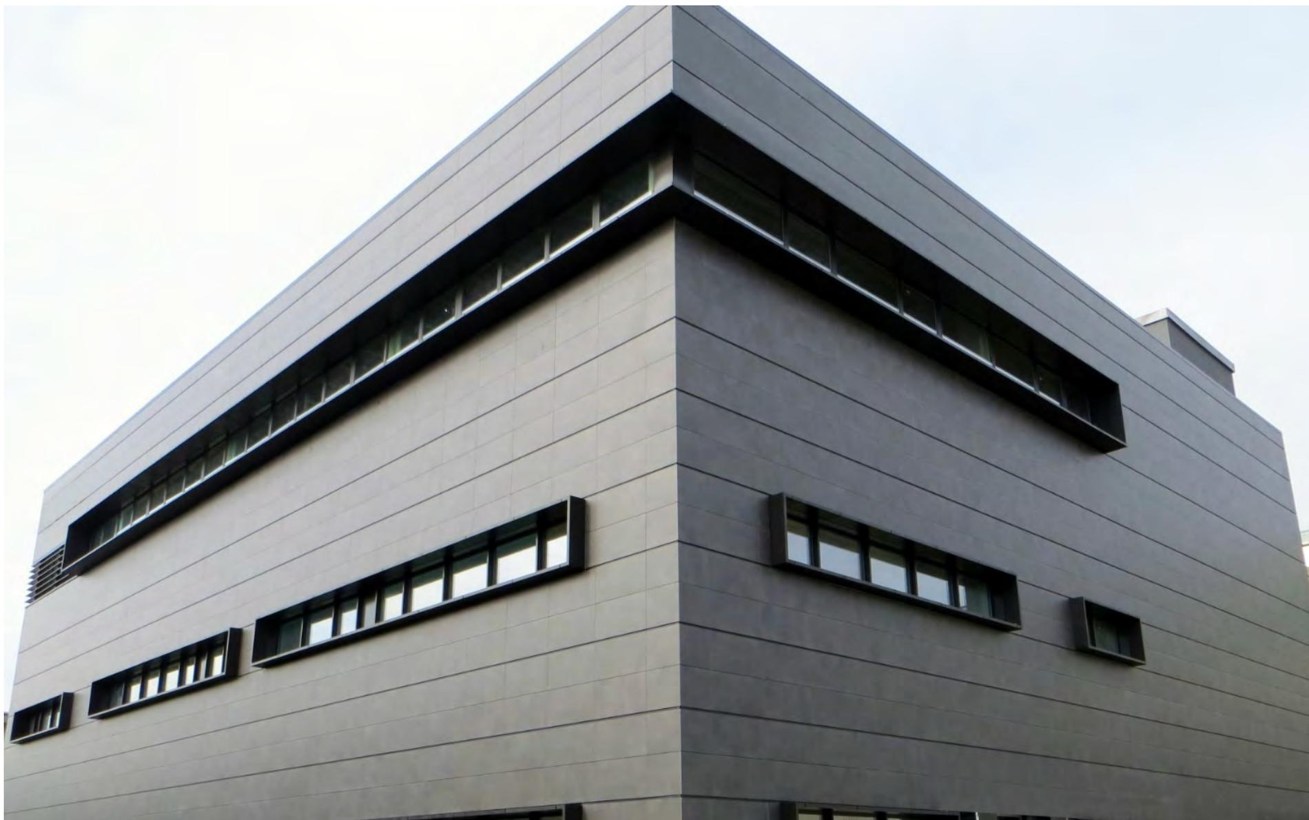
**PARMA – Edificio industriale farmaceutico (Progetto CMR, Ponzi srl 2015)** Progetto costruttivo di serramenti, raccordi in lamiera e frangisoli inseriti in facciata del nuovo edificio industriale farmaceutico.
