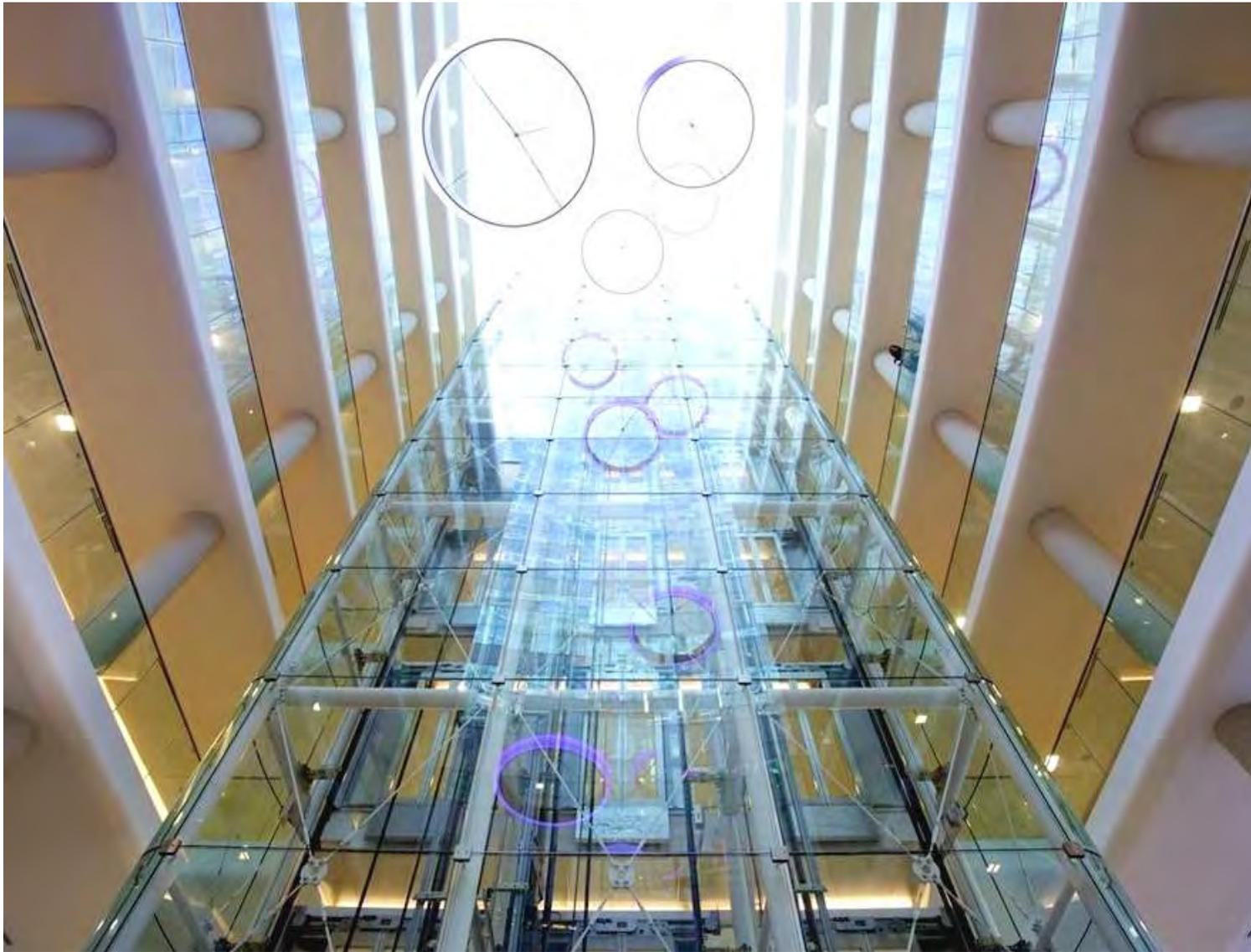
**Da Vinci Business Center (INGENIUM RE srl, arch. Marco Tamino, 2011)** Il vano di corsa vetrato dell' ascensore panoramico situato nel roof garden del Da Vinci Center è realizzato con un sistema di fissaggi puntuale del tipo a pinza meccanica. I vetri delle pareti sono bombati a diverse raggature. L'altezza a vista dell'ascensore panoramico è superiore ai 30 metri
